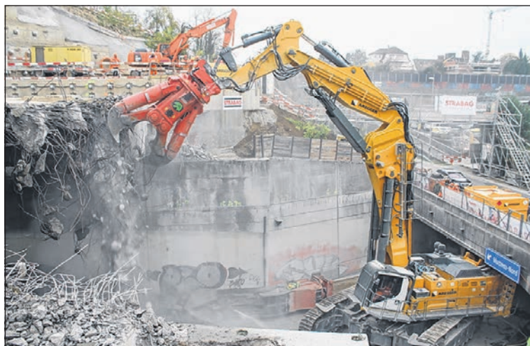
Im November wird der Hagnau-Tunnel abgerissen. Dabei kommt «A-Rex», Europas grösster Rückbaubagger, zum Einsatz. Fotos Archiv BA
