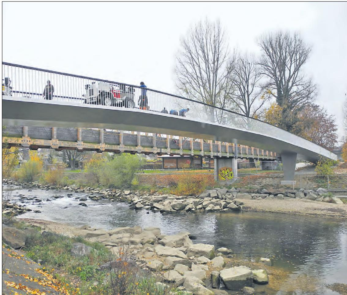
*Blick zurück: Im November 2011 spannte sich der im Bau befindliche Birskopfsteig noch parallel zum 2008 installierten Holzbrückenprovisorium über die Birs. Rund 40 Tonnen Gussasphalt wurden auf den Steig aufgetragen und verhalfen ihm zum offiziellen Namen «Schwebender Asphalt». Archivfoto Gemeindeverwaltung Birsfelden*
