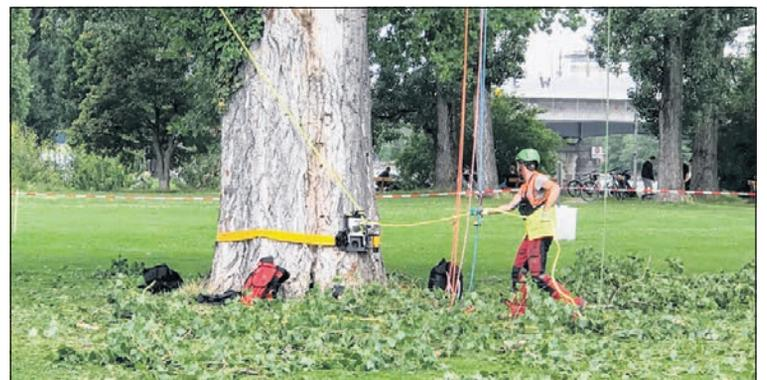
Schwerere Äste werden mit einem Seilzug, dessen Widerstand am gelben Band am dicken Stamm befestigt ist, sanft zu Boden gebracht.
