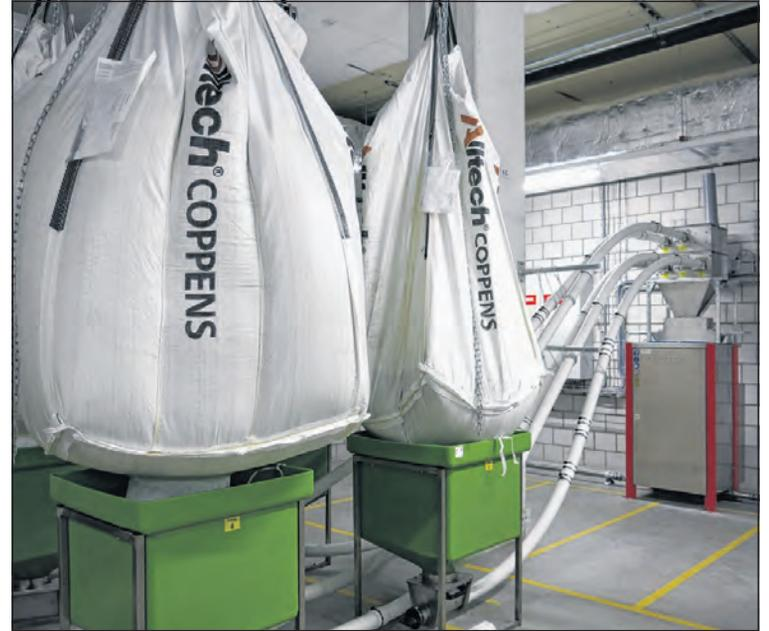
Die Fütterung der Fische in den momentan 25 belegten Haltungsbecken erfolgt voll automatisiert über diese Anlage.
