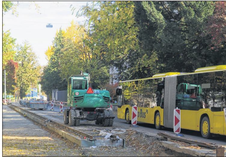
Der Grund, warum Birsfelden zurzeit nicht mit dem «Drämli», sondern mit dem Bus erschlossen ist: Die Erneuerung der Tramgleise in der der St.-Alban-Anlage. Fotos Georges Küng
