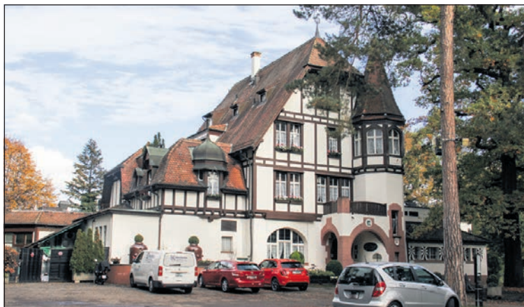
Das Waldhaus wird renoviert und ausgebaut. Ein neuer Pächter steht in den Startlöchern bereit.
