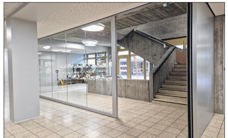
Diese Glaskonstruktion gewährleistet, dass die Treppe im Ereignisfall brandfrei bleibt.
