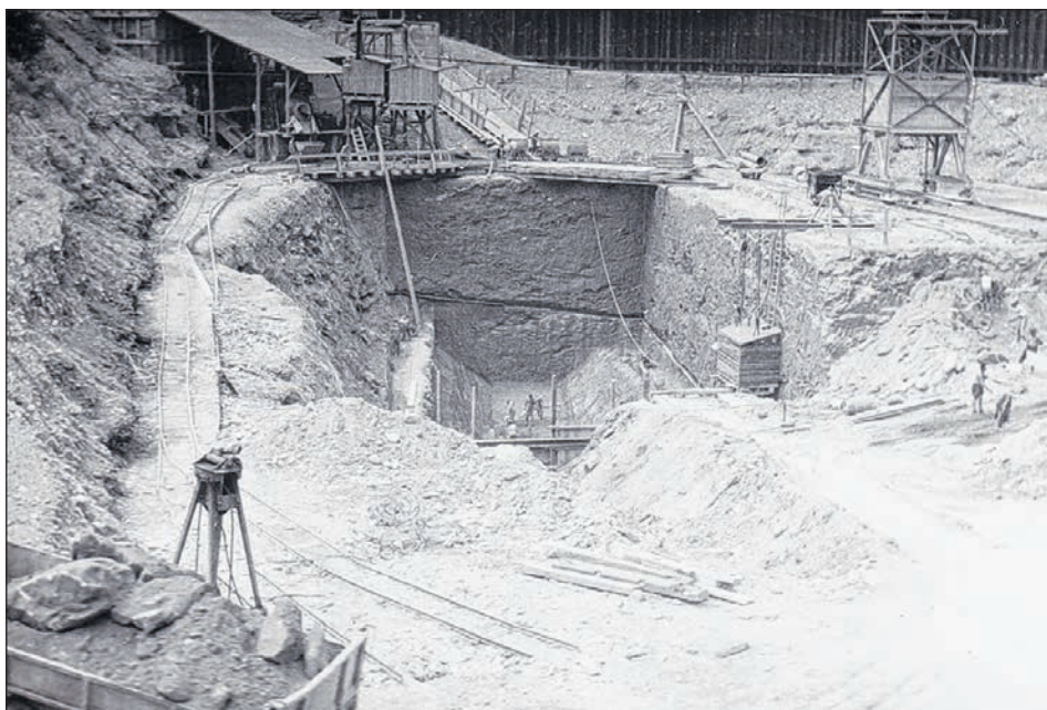
Die Bauarbeiter in der Grube scheinen zwergenhaft klein in der riesigen Baustelle.
