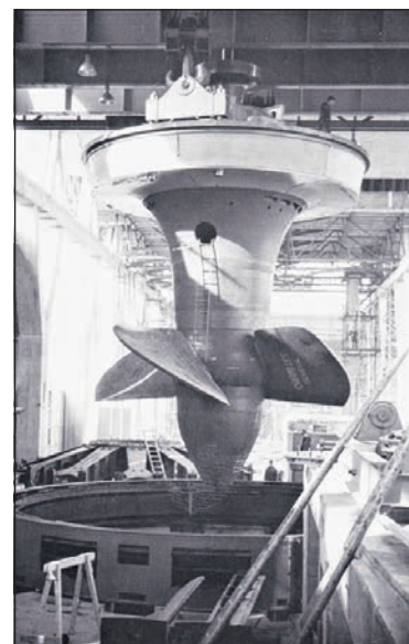
Vier Turbinen wurden eingebaut, jede wiegt rund 140 Tonnen.
