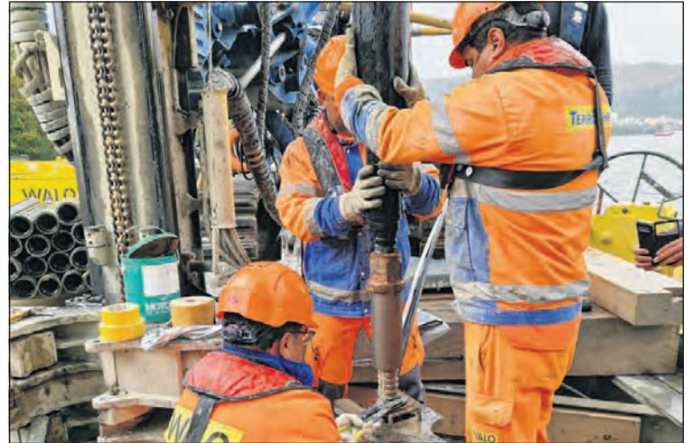
Einer der Mikropfähle wurde soeben in die Öffnung eingelassen und wird nun befestigt.
