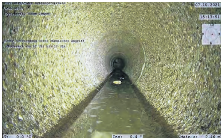
Bevor eine Kanalsanierung zustande kommt, befährt ein Roboter das Altrohr und bestimmt die Lage.
