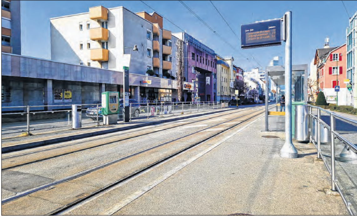
Gemäss dem Regierungsrat müssen die Tramgleise zwingend saniert und die Haltestellen dringend umgebaut werden, damit sie dem Behindertengleichstellungsgesetz entsprechen.
