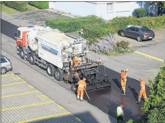
Es geht vorwärts: Die zweite Schicht des neuen Asphaltbelags wird aufgetragen.
