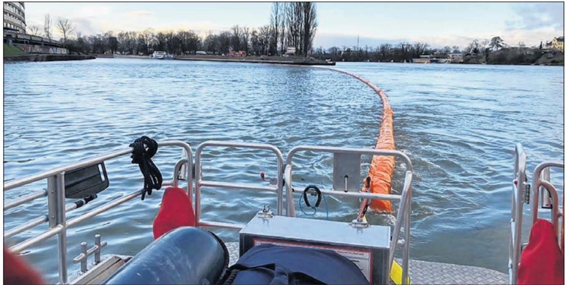
Ölwehr nach Flutwelle. Das Mehrzweckboot «Pegasus» bringt bei der Spitze der Kraftwerkinsel Birsfelden die grosse, 200 Meter lange Ölsperre in Stellung.
