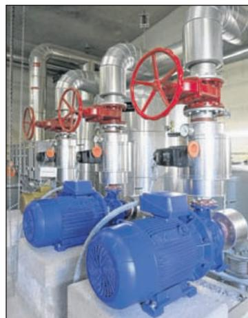
Die Fernleitungspumpen pumpen das Warmwasser zu den Häusern.
