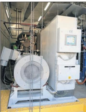
So sieht die neue Wärmepumpe aus, die ein altes Aggregat ersetzt.
