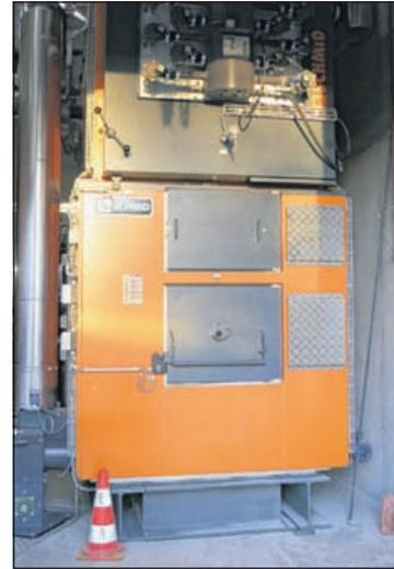
Der neue Holzsnitzelkessel besitzt eine Leistung von 850 Kilowatt.
