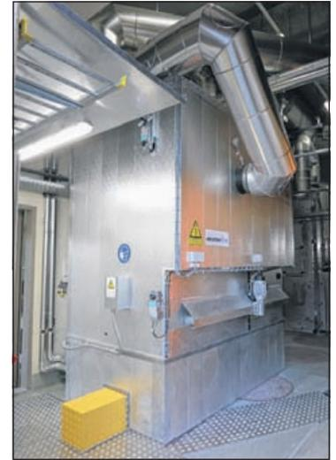
Ein Elektrofilter sorgt dafür, dass kein Feinstaub entweicht.
