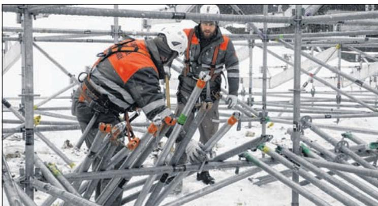
Mikado im Schneetreiben. Die Zuschauertribüne im Zielraum besteht aus Hunderten von Gerüststangen, die von Zivilschutzangehörigen zusammengesetzt werden.
