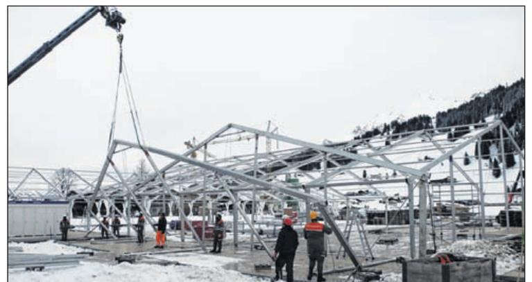
Aufrichte mit Kran. Die zuvor von den Zivilschutzangehörigen aus Hunderten Einzelteilen zusammengesetzten Zeltteile werden mit einem Mobilkran aufgestellt und verankert.
