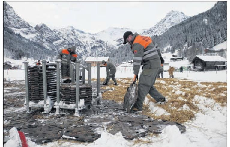
Auf einer Winterwiese wird für den Busverkehr am Rennwochenende eine Behelfsstrasse aus 20 kg schweren Stahlplatten verlegt.
